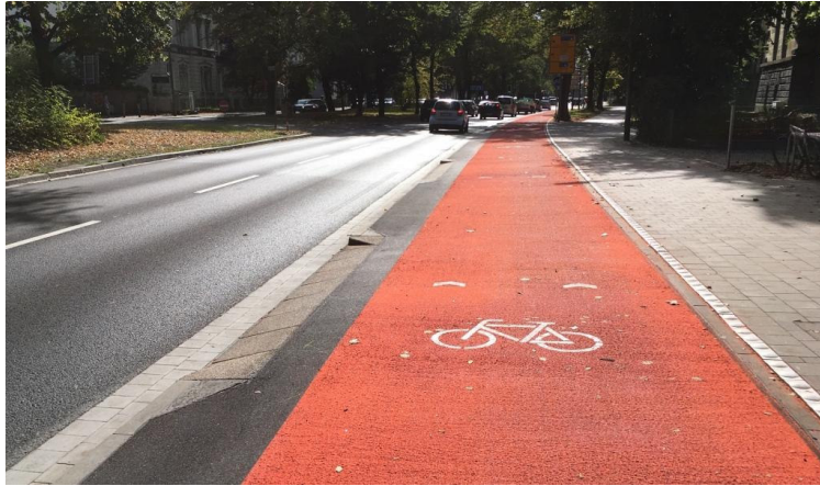
Asphaltierter baulicher Radweg mit Sinussteinen zur Verlangsamung von Kfz-Abbiegern
